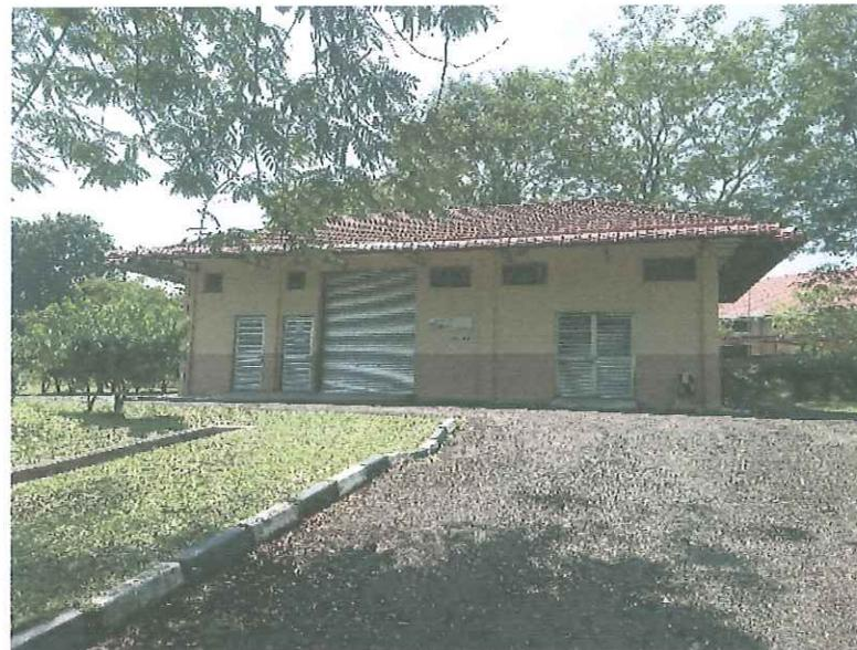
Sebuah bangunan yang menerima bekalan elektrik dari Nur Distribution Sdn Bhd sebanyak 11KV dan diagih dan diterima dari SubStation-Sub Station yang terdapat di dalam PTSB. Bangunan yang mempunyai satu ruang bilik yang menempatkan Air Circuit Braker (ABS) Board.
