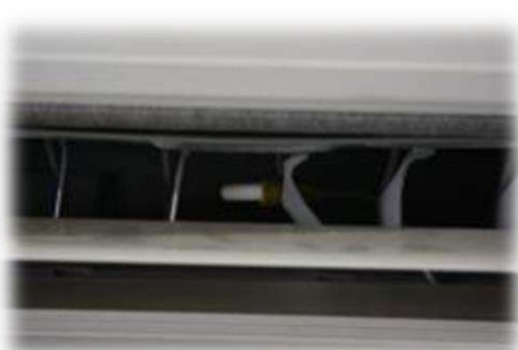
Rajah 8: Pemasangan sensor di bahagian dalam penyaman udara
