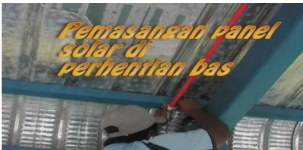
Rajah 3: Pemasangan sistem lampu solar di hentian bas.
