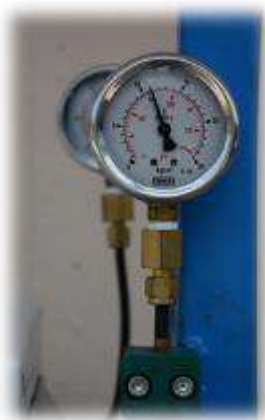
Rajah 4: Pemasangan meter gas
