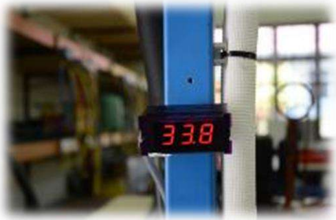
Rajah 6: Pemasangan thermometer digital pada outdoor unit
